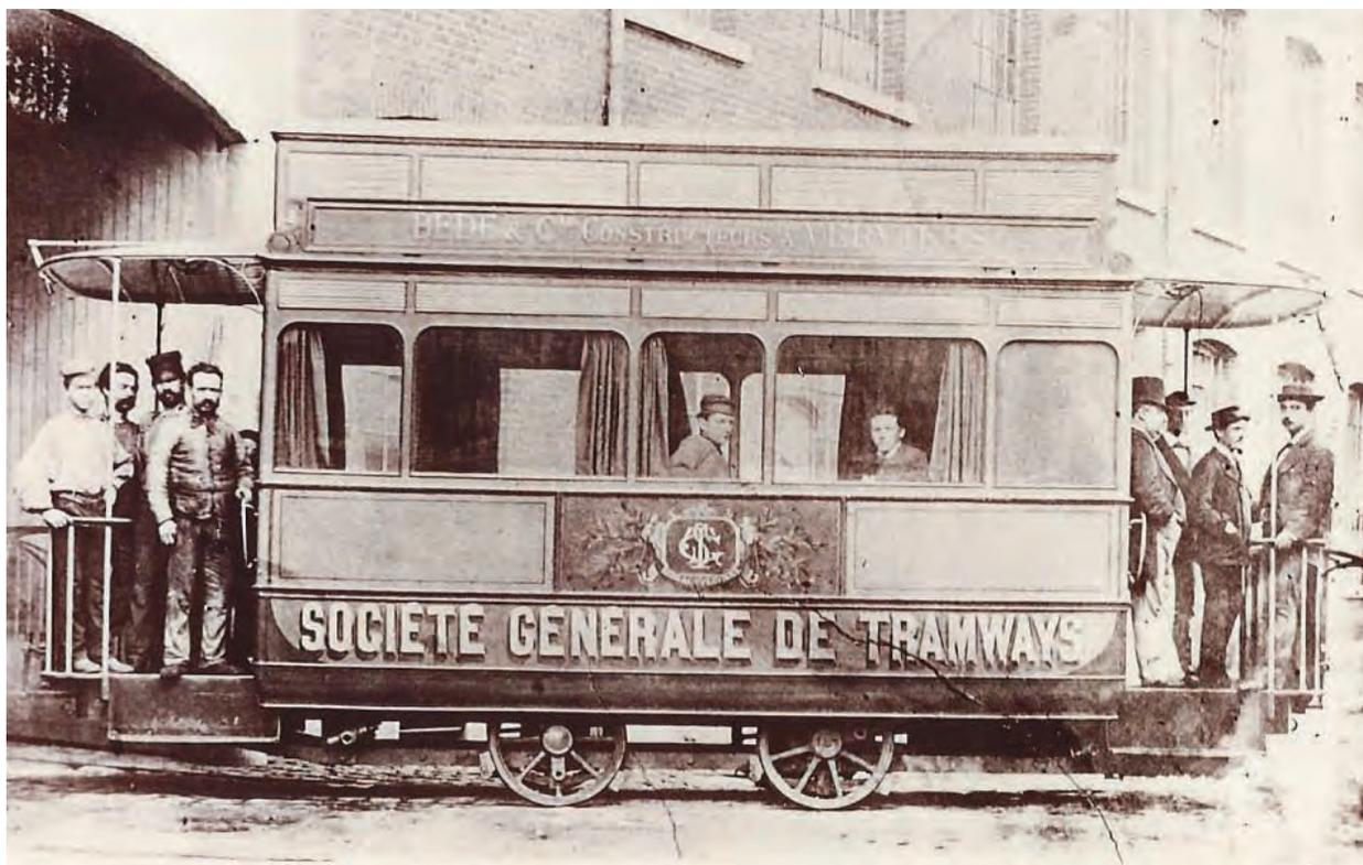
Fig. 1 : « Tram-car à vapeur sans feu et à condensation complète », photo par Edouard Wettstein, 1876, collection Joëlle Breuer, Verviers.
