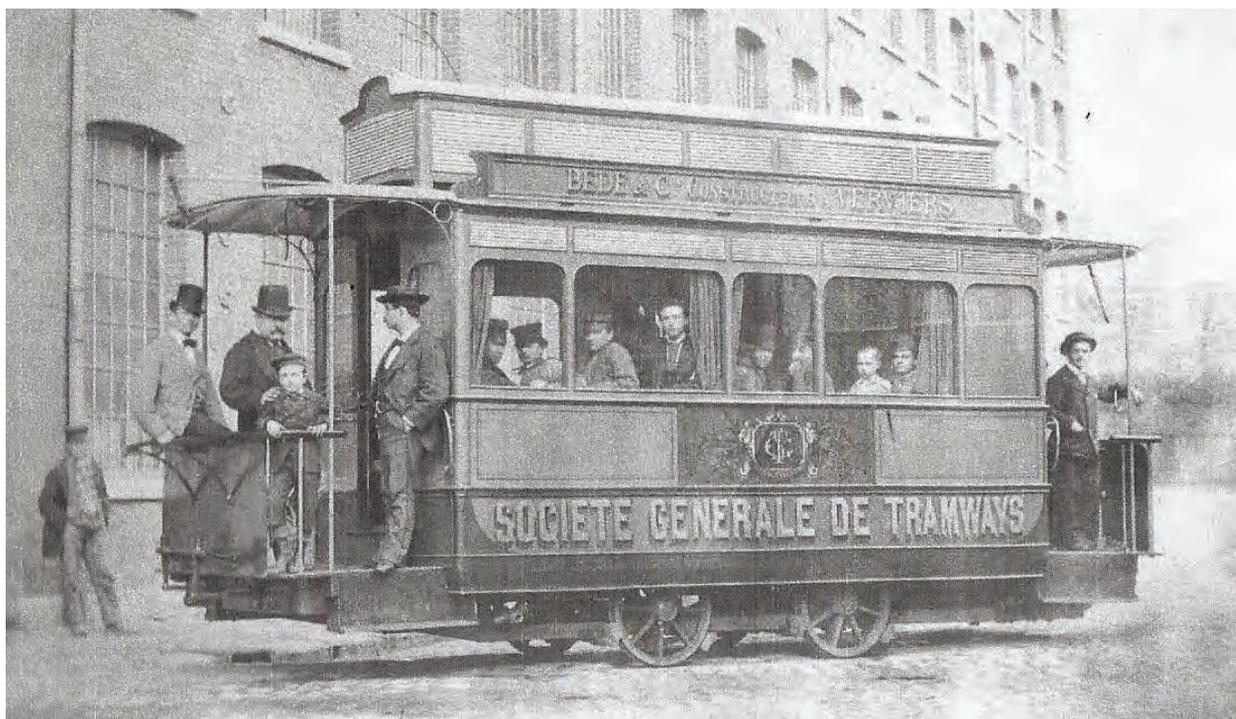
Fig. 2 : « Tram-car à vapeur sans feu et à condensation complète », photo par Edouard Wettstein, 1876, collection Georges Henrard, Verviers.
