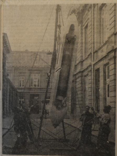
La navette géante hissée dans la cour de l'Ecole des Textiles.
