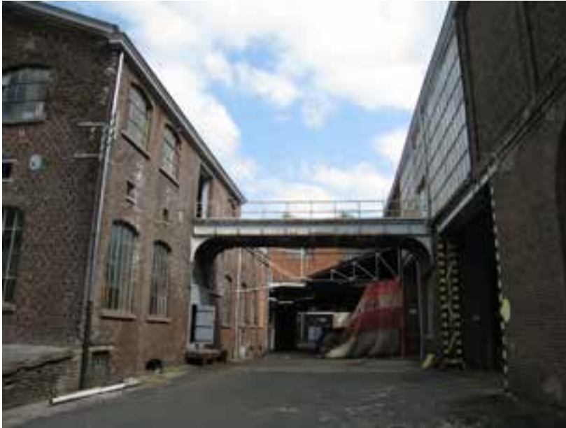
Fig. 114 La passerelle reliant le triage et le solvantage dans les anciens bâtiments.
