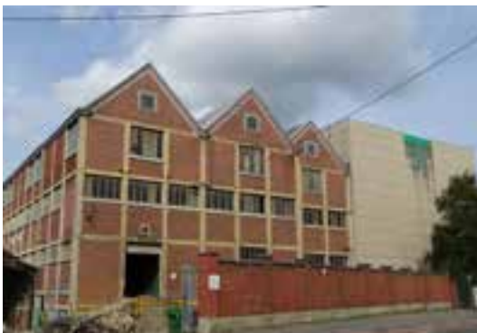
Fig. 115 L'usine dite « Casino » (anciennement « La Vesdre »).
