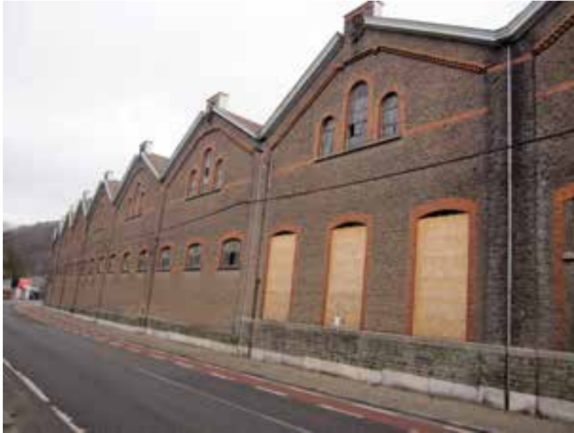
Fig. 95 Le bâtiment du Solvent.
