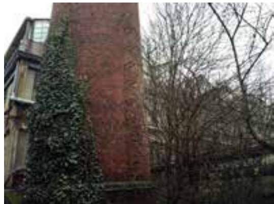
Fig. 99 Le pied de la cheminée des chaudières.
